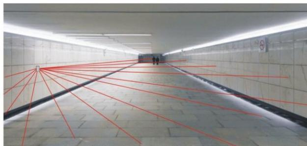
Управление освещением подземных переходов с функцией диммирования, контроль присутствия.
