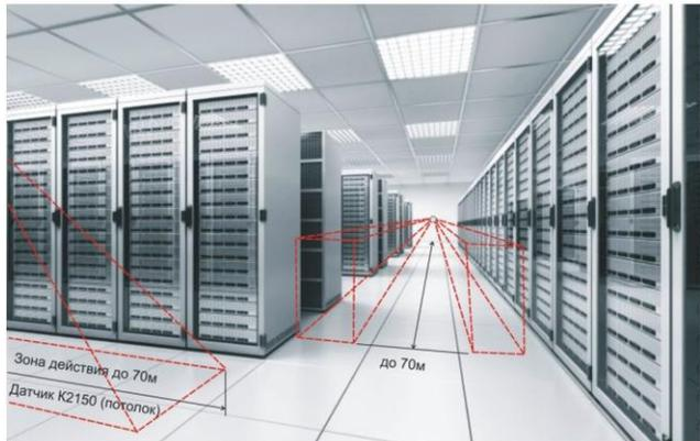
Один датчик контролирует до 70 м аллеи между стойками серверов, заменяя собой 3-4 импортных датчика движения. В охлаждаемых помещениях применение принципа "Свет по потребности" дает максимальный экономический эффект, т.к. светодиодные светильники расходуют около 80% потребляемой энергии на выделение тепла и только 20% - на излучение света.
